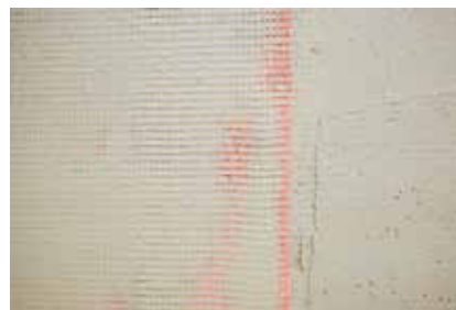
IN FASE DI POSA
